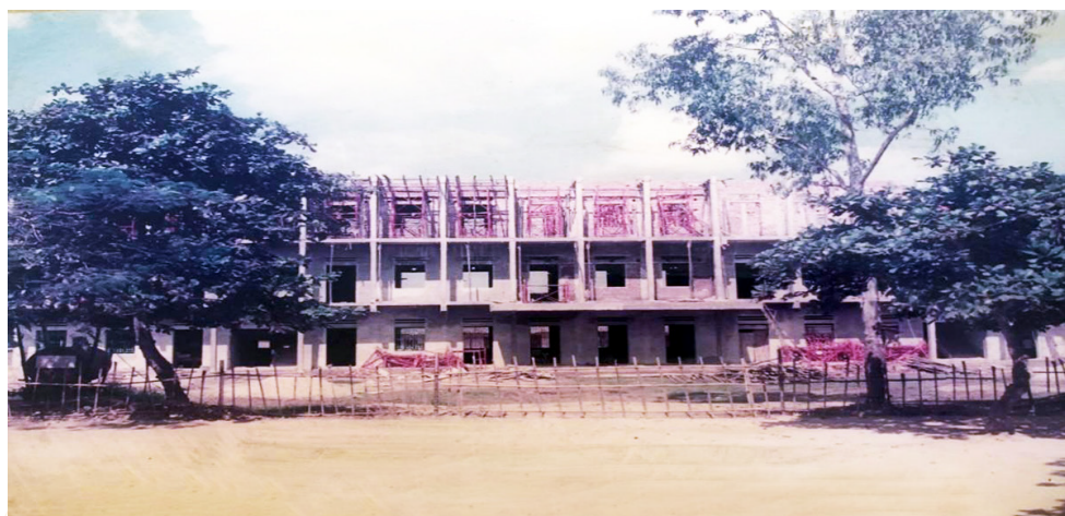
Công trình phòng học trong thời gian thi công (tháng 10/2000)
